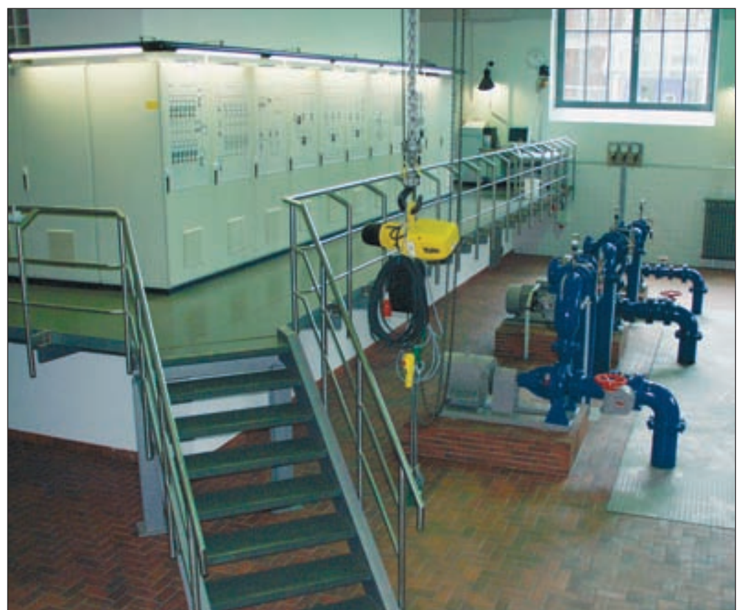
Am Sonnabend, 20. September, lädt das Wasserwerk Neugraben, Falkenbergsweg 36, von 11.00 bis 17.00 Uhr zu einem Tag der offenen Tür ein.
