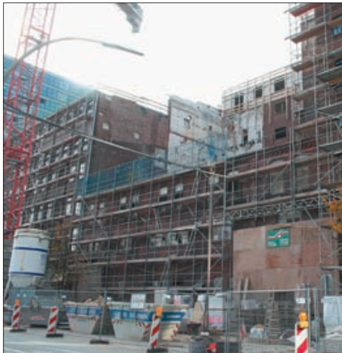
Im mittleren Bereich des Fleethauses soll im Bereich der 4. Etage die erste Kita nebst großem Dachgarten im Channel entstehen
