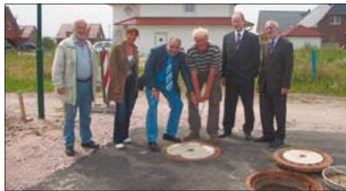
Zur Abnahme der Erschließungsarbeiten gehörte auch die Inspektion des Entwässerungskanal. Helmut Beyermann (technische Bauabteilung, Gemeinde Neu Wulmstorf), Projektleiterin Rita Pape (UDG), Thomas Saunus (Abteilungsleiter Ortsentwicklung/Immobilienwirtschaft, Gemeinde Neu Wulmstorf), Thomas Rieveschl (Firma Boes Bau) Volker Eggers (Volksbank Nordheide), Neu Wulmstorfs Bürgermeister Wolf-Egbert Rosenzweig (v.l.n.r.) waren dabei. Im Hintergrund die bereits im ersten Bauabschnitt entstandenen Eigenheime im „Haselhof“. Foto: vb
