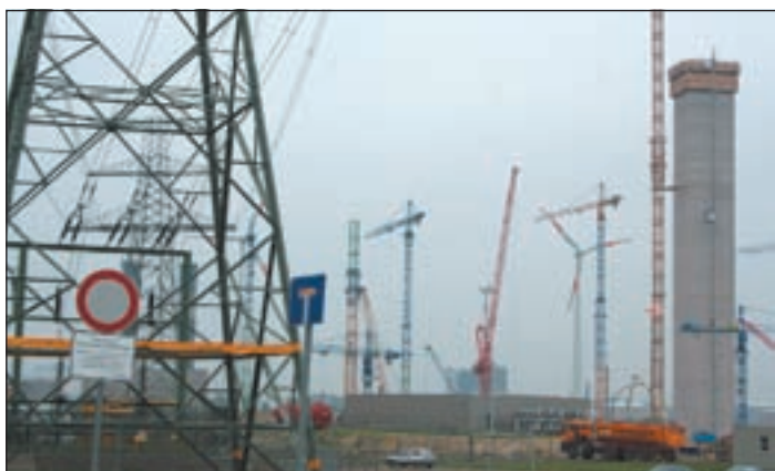
Die Baustelle für das Kohlekraftwerk in Moorburg: Nach der mit Auflagen bestätigten Baugenehmigung gehen die Arbeiten jetzt richtig los. Foto: Müntz
