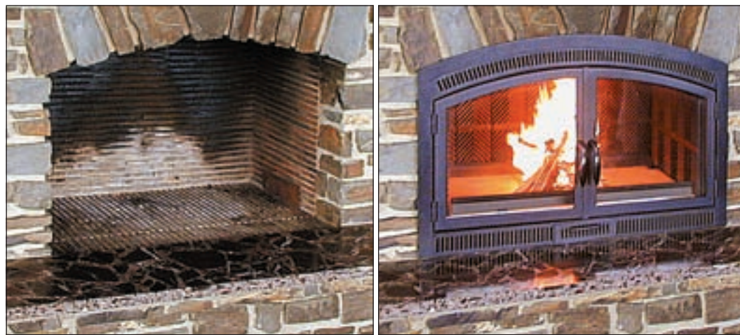
Optimieren Sie Ihren Kamin mit einer Kaminkassette von Spartherm. Die Fotos zeigen einen Kamin vor und nach dem Umbau.
