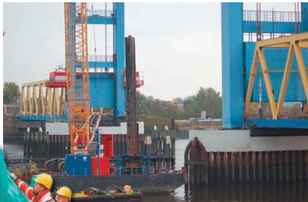
Auf dem 60x30 Meter großen Ponton steht ein 280 Tonnen schwerer Raupenkran, der die maschinenbaulichen Teile vorsichtig über das Maschinenhaus hebt. Fotos: Koltermann
