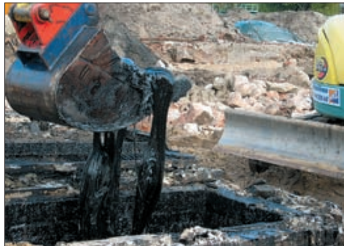
Entleerung einer Teerölgrube.
