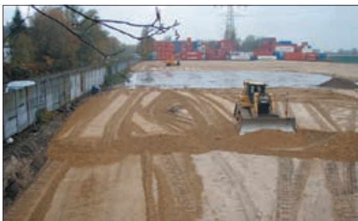
So sieht die Fläche heute nach der abschließenden Herrichtung und dem Einbau von Füllboden aus.
