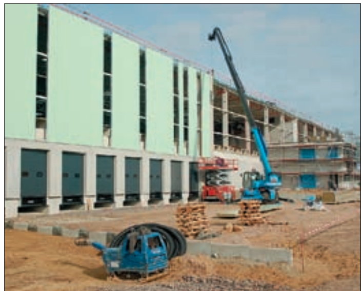
Noch ist es ein Rohbau, doch im Herbst 2009 soll die GEODIS-Anlage bezugsfertig sein.
