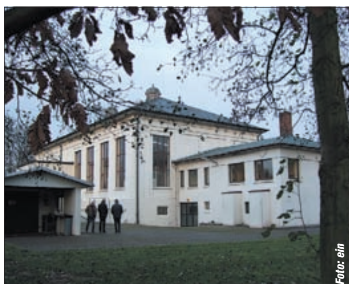
Das Wilhelmsburger Wasserwerk wird zum Gartenrestaurant umgebaut. Foto: ein
