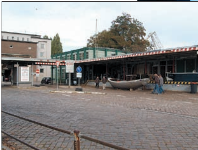
Die Alte Zollstation vor dem Alten Elbtunnel. Sie muss weichen für eine Großbaustelle.
