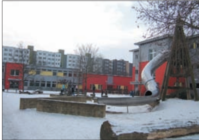
In warmen Tönen leuchten die neuen Fassaden nach der Sanierung der Schule An der Burgweide. Foto: ein
