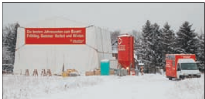
Trotz Eis und Schnee gehen die Handwerker ihren Arbeiten an zwei Neubauten der Viebrockhaus AG im Neubaugebiet „Elbmosaik“ unter beheizten Zelten nach. Foto: Koltermann
