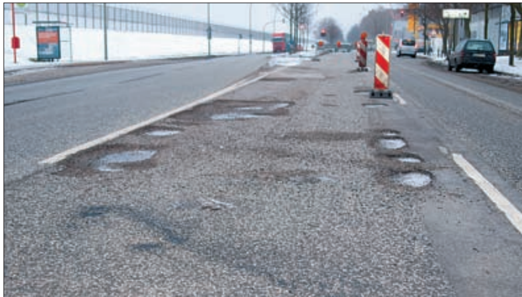
Die Harburger Chaussee ist mittlerweile im Bereich der Schlaglöcher gesperrt. Foto: Ubben
