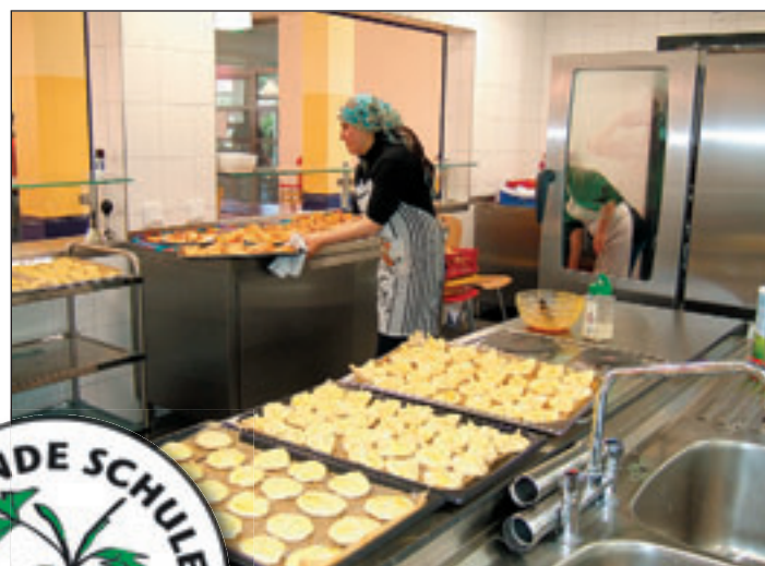
Die neue Küche der Grundschule An der Burgweide bietet alles, was zur Zubereitung von gesundem Essen benötigt wird. Foto: ein
