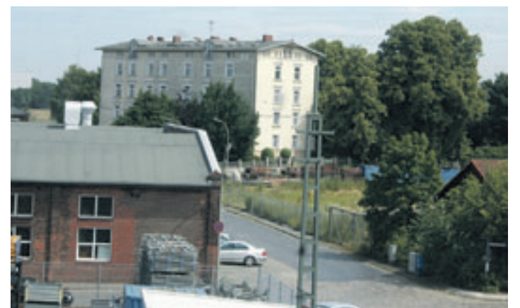
...und das ist heute davon übrig geblieben, ein Mietshaus. Dahinter entsteht das Neubaugebiet Balance Bay Fotos: pm
