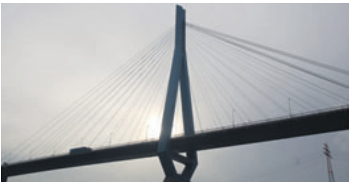
Die Hamburg Port Authority muss für Instandsetzungsarbeiten die Köhlbrandbrücke sperren. Foto: mk
