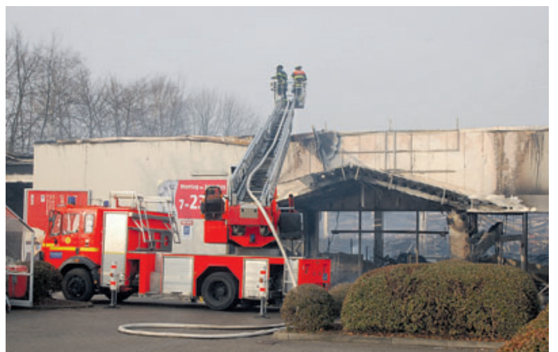
Trotz des schnellen Eingreifens der Feuerwehr brannte der Rewe-Markt vollständig ab.
