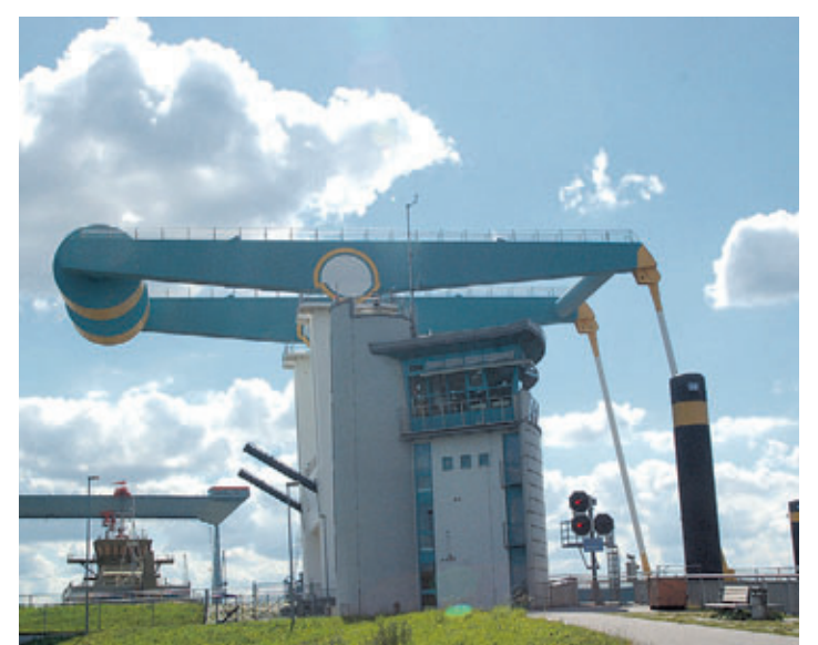
Bis zum Morgen des 10. September ist die Brücke über dem Este-Sperrwerk wieder für den Verkehr freigegeben.
