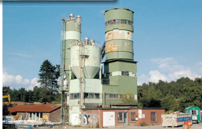
Architekt Helmut Urbschat will die Türme des Beton-Werkes in sein Projekt integrieren. Foto: mk
