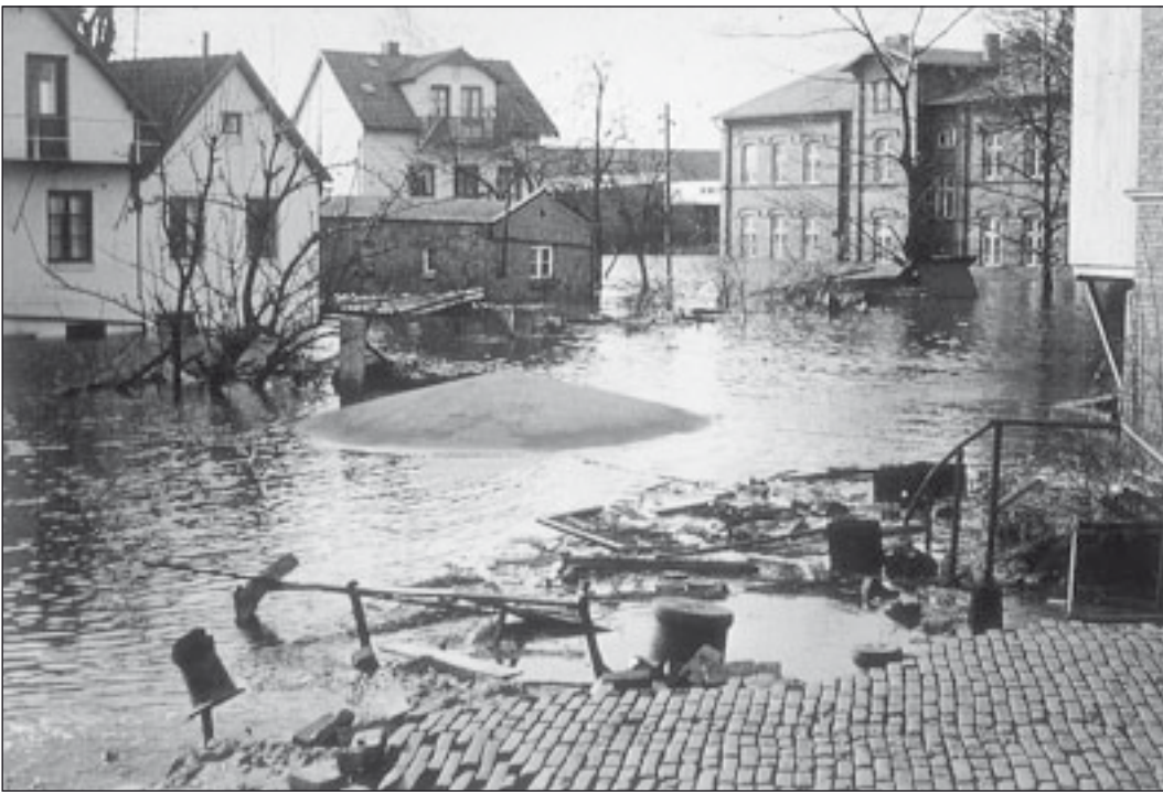
Die Aueschule vom Deich aus gesehen – den Krieg hat der Pilzbunker überstanden, die Flut hat ihm zugesetzt Foto: Schwartau
