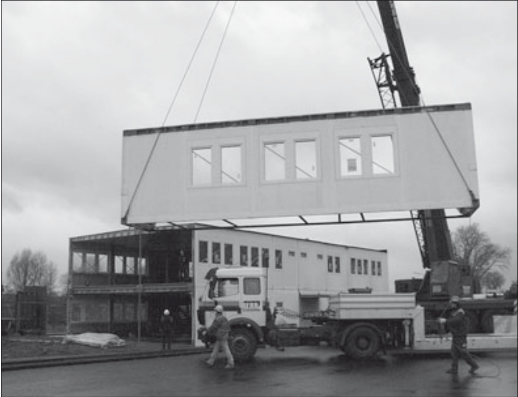
Ein Tele-Kran hievt eines der Module an seinen Platz
