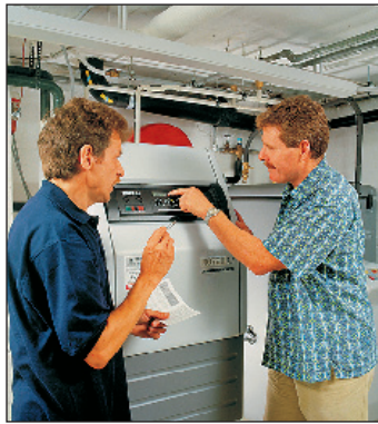
(spp) Die neue Heizung ist fertig montiert. Im Energiepass wird dokumentiert, wie viel Energie sie durchschnittlich benötigt. Foto: Rotex
