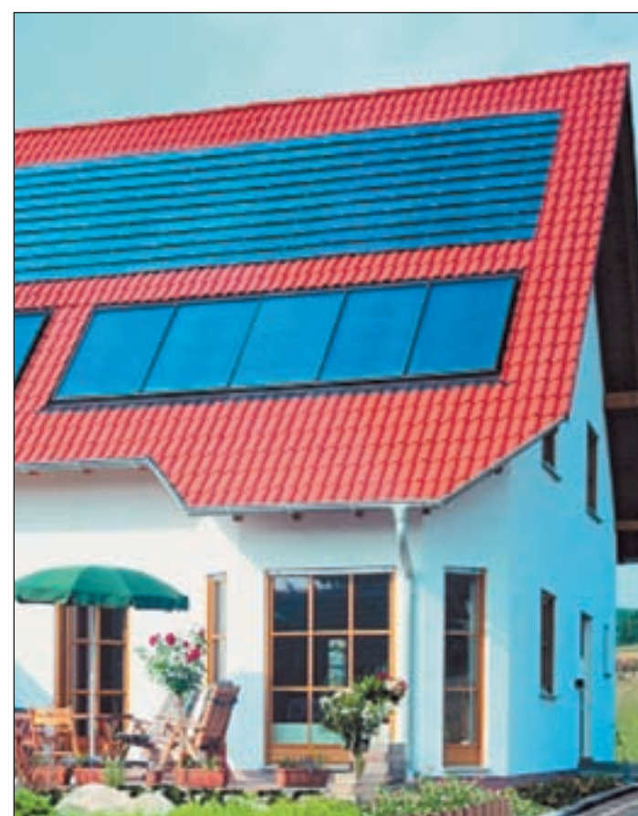
bbs/Du. Für die Anlage von Hightechanlagen auf dem Dach gibt es gute Gründe. Foto: Braas
