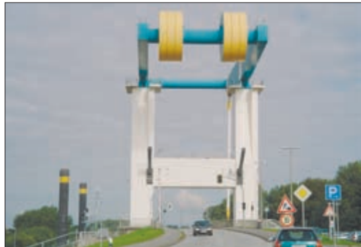
Beinahe anderthalb Tage behinderte die defekte Hubbrücke des Este-Sperrwerks den Verkehr im Süderelberaum. Foto: Koltermann
