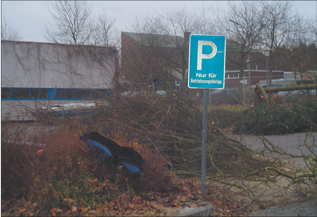
Auf dem ehemaligen Karstadt-Gelände haben Arbeiter einzelne zu niedrig hängende Äste und kleinere Bäume abgesägt, damit Baufahrzeuge ungehindert zur Baustelle gelangen können.
