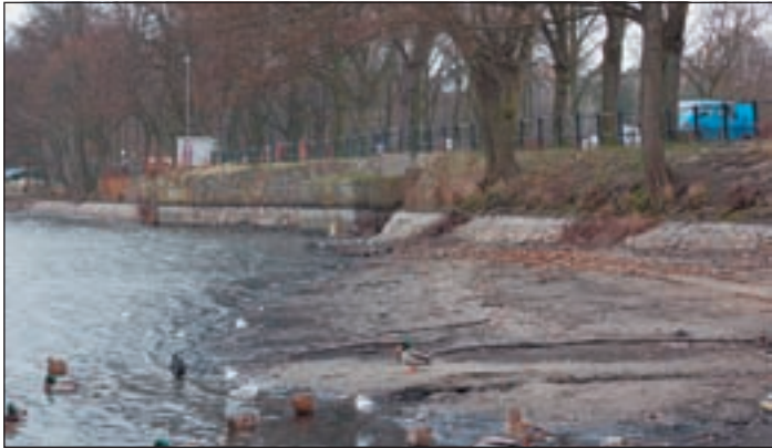
Um eine dringende Reparatur am Ablaufbauwerk vornehmen zu können, wurde der Wasserstand der Außenmühle auf 1,50 Meter reduziert. Neben viel Unrat kommen nun verrostete Schienen zum Vorschein, auf denen in früheren Zeiten Loren zum Transport von in Massen gefangenen Fischen geschoben wurden.
