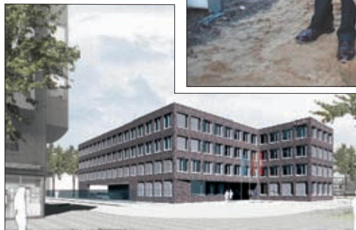
Rot-blau-bunter Klinker, Stahl und Glas werden das Erscheinungsbild des neuen Polizeikommissariats prägen. Foto: Prof. B. Winking Arch. BDA.
