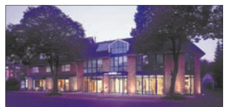
Effizient, sparsam und vom Staat bezuschusst – der Zeitpunkt für eine Brennwert-Heizungsanlage war selten günstiger.
