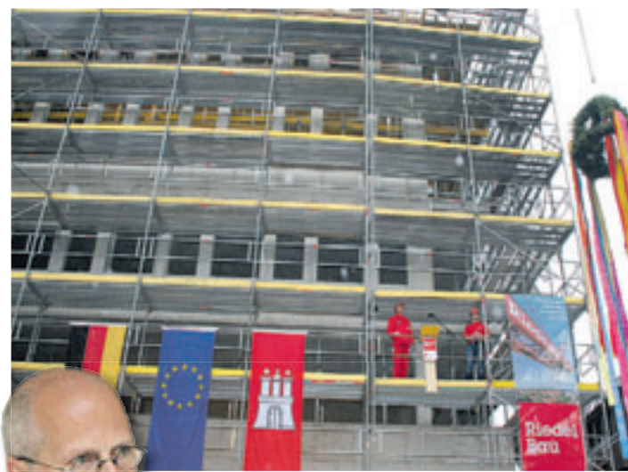
Im Rathausforum über dem am Mittwoch der Richtkranzschwelte, werden elf Dienststellen unter einem Dach zusammen geführt
