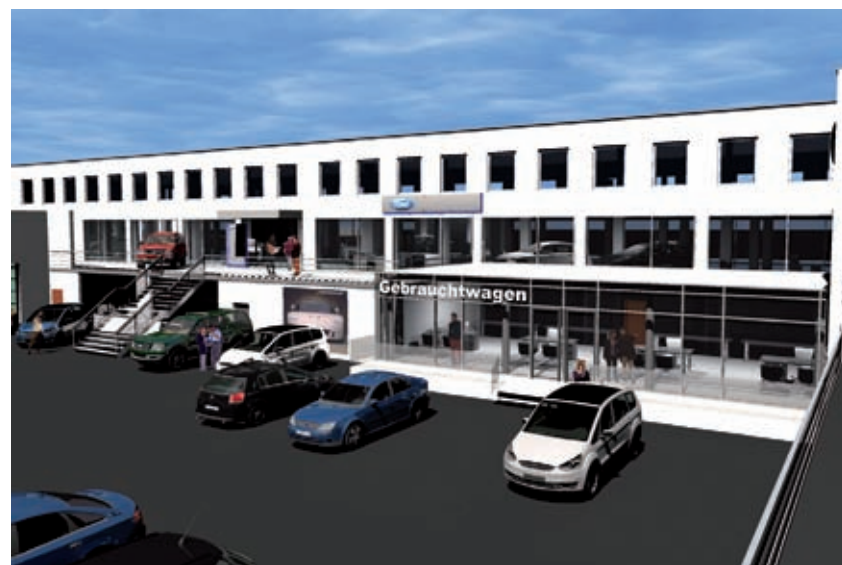
Hell und freundlich werden sich im kommenden Jahr die neuen Verkaufsräume im Harburger Ford-Betrieb Tobabens präsentieren. Der Umbau ist bereits im vollen Gange.
