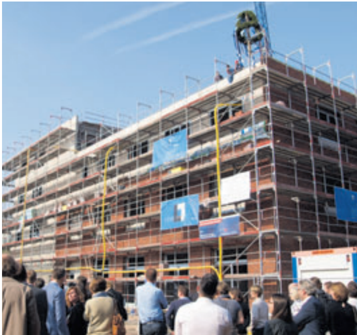
Im September 2017 konnte das traditionelle Richtfest für den neuen Elbinsel-Campus gefeiert werden, Mitte nächsten Jahres sollen die neuen Gebäude genutzt werden können. Foto: au
