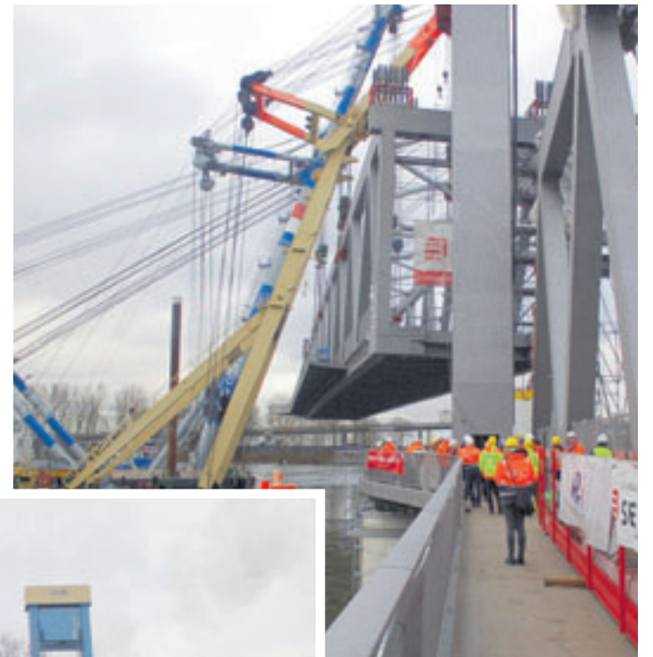
Millimeter für Millimeter transportierten die gewaltigen Schwimmkräne „Matador 3“ und „Enak“ das Hubteil zum Einsatzort
