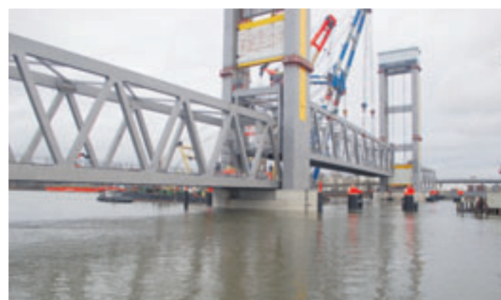
Auch von der Seite sah das Einhängen des Hubteils bemerkenswert aus
