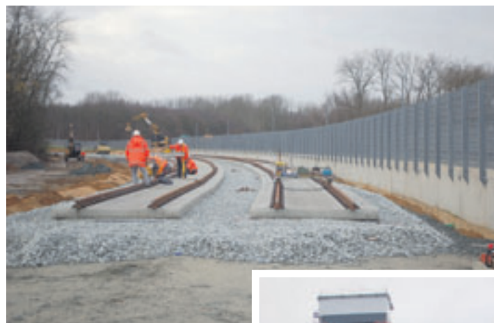
Die neuen Gleisanschlüsse sind so gut wie fertig
