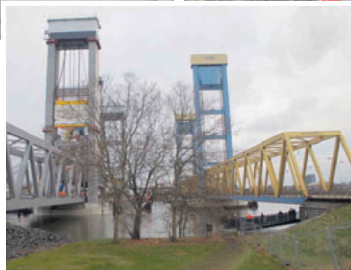
Einträchtig nebeneinander: Links die neue Bahnbrücke Kattwyk, rechts die alte Kattwykbrücke Fotos: mk
