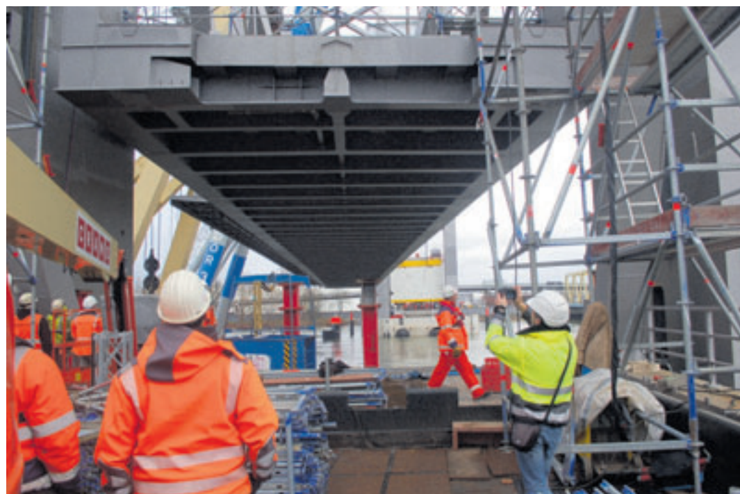
Es dauerte mehrere Stunden, bis das Hubteil schließlich eingehängt werden konnte
