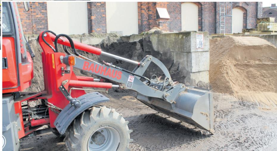
Das Schüttgut wird mittels Radlader bewegt.
