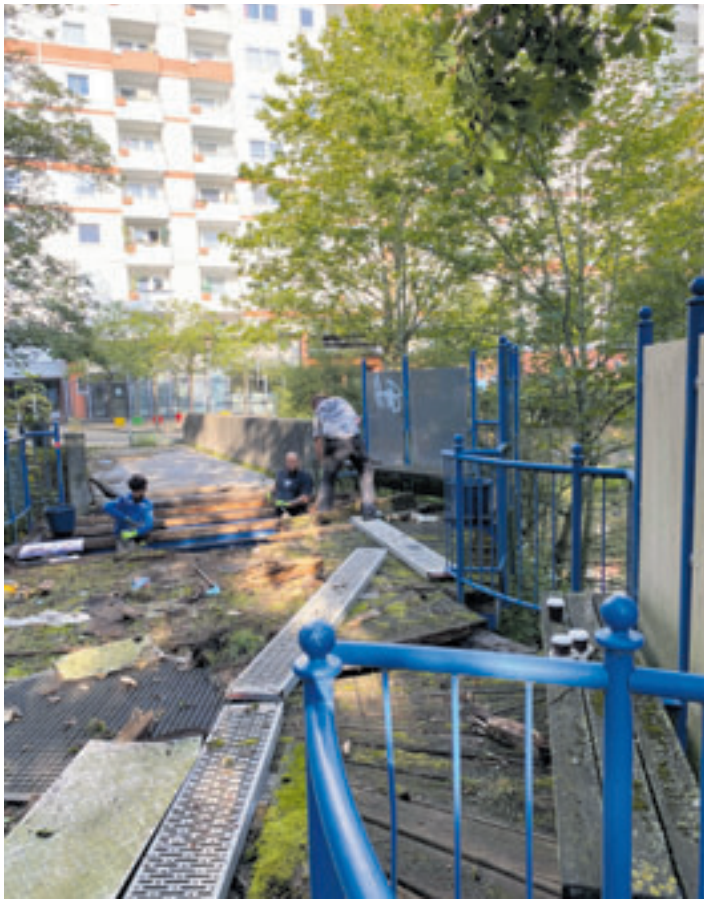
Nach sechs Jahren wird die Fußgängerbrücke am Erlerring 8 endlich saniert. Mitarbeiter des Bezirksamts Hamburg-Mitte reißen die marode Brücke ab. Foto: BA Hamburg-Mitte
