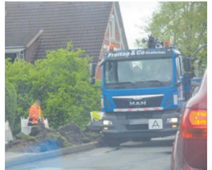
Am 15. April begannen die vorbereitenden Maßnahmen zur Einrichtung der neuen Bushaltestelle 550 in der Nincoper Straße Foto: mk
