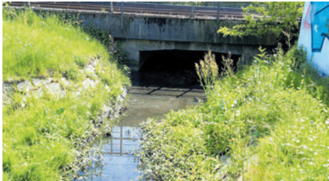
Welche Maßnahmen wurden an Durchläufen unter Straßen (z.B. Falkenbergsweg, Cuxhavener Straße, Kleinfeld, In de Krümm, Neuwiedenthaler Straße) durchgeführt? Foto: W. Marsand
