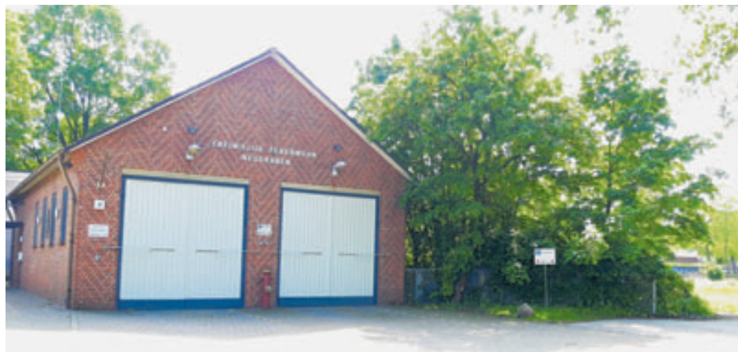
Das Areal rechts vom Feuerwehrhaus soll für ein Rückhaltebecken genutzt werden Foto: W. Marsand
