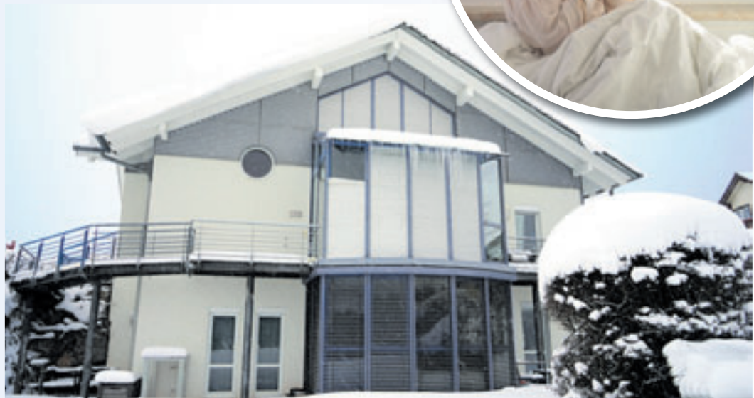
Rollläden sind mehr als sommerlicher Hitzeschutz. Sie helfen im Winter maßgeblich beim Energiesparen, indem sie das Entweichen von Wärme durch die Glasflächen verhindern und Innenwärme speichern Foto: Schanz
