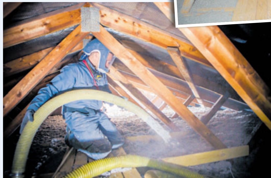
Die Dämmflocken werden maschinell direkt auf den Flächen verteilt, die nicht betreten werden Foto: Climacell
