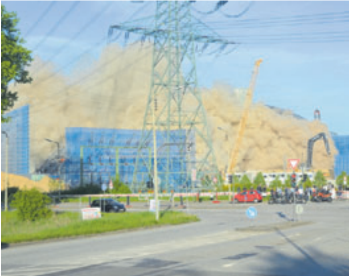
Wie hoch sind die Belastungen für die Bürger durch die Abrissarbeiten beim ehemaligen Kohlekraftwerk Moorburg?, möchte die Volt-Partei wissen. Foto: mk
