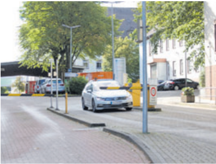
Am 8. September kam es im Technikbereich der Notaufnahme des AK Harburg zu einem Brand Foto: mk
