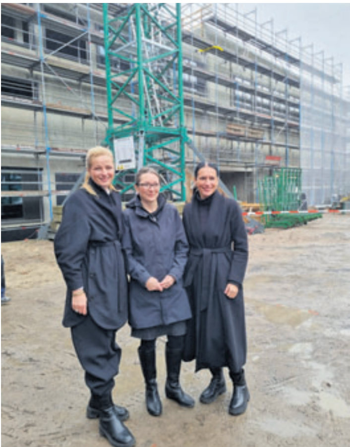
Liane Koch-Wießner, Schulleiterin des Gymnasiums Neugraben, Ksenija Bekeris, Bildungssenatorin und Mandy Herrmann, Geschäftsführerin von GMH | Gebäudemanagement Hamburg (v.l.n.r.) zeigten sich von den baulichen Fortschritten des zweiten Bauabschnittes angetan
