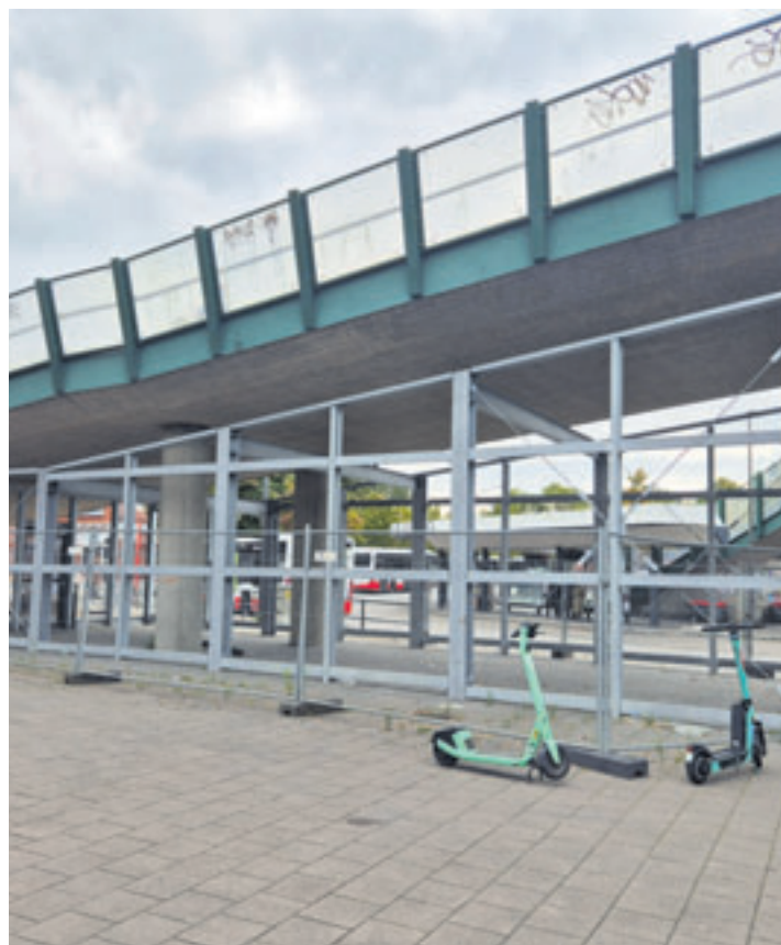
Unter der Muharrem-Acar-Brücke können die Wilhelmsburger bald sicher ihre Fahrräder abstellen Foto: au
