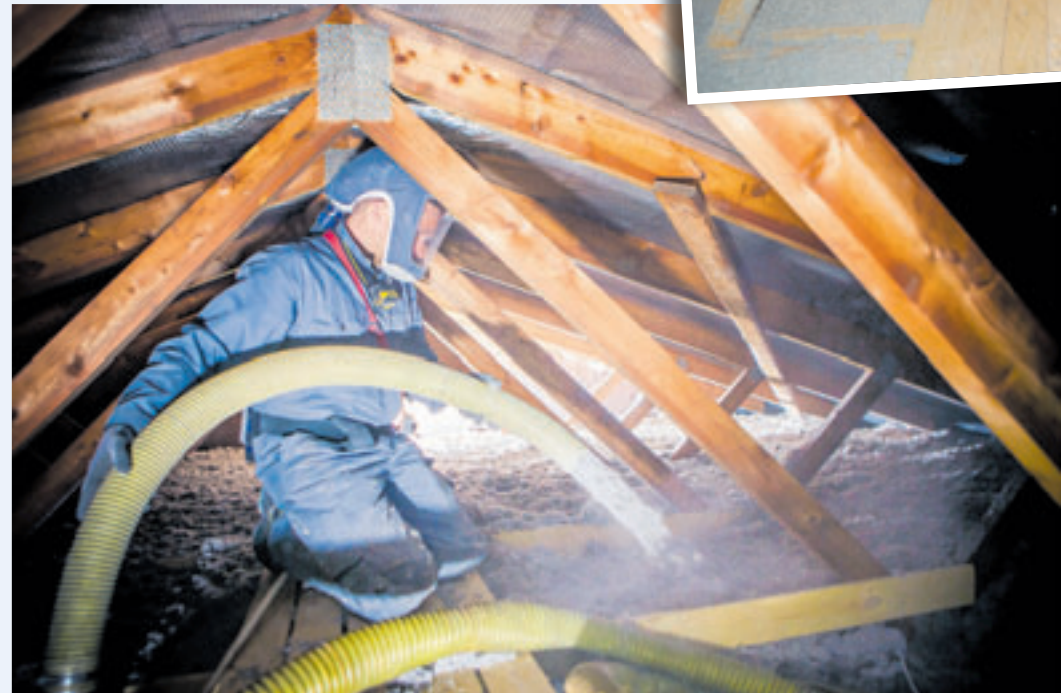
Die Dämmflocken werden maschinell direkt auf den Flächen verteilt, die nicht betreten werden Foto: Climacell
