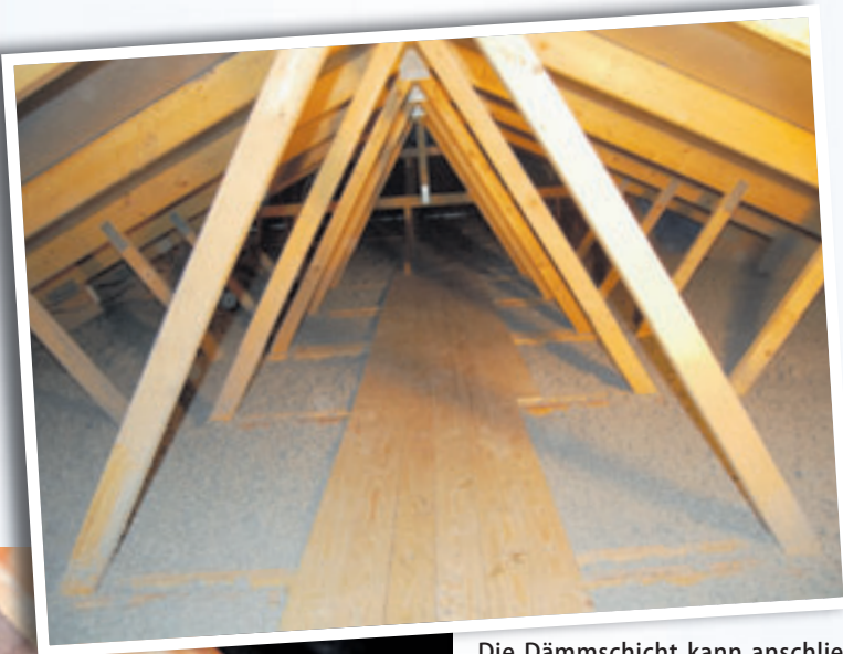
Die Dämmschicht kann anschließend mit Wasser besprüht werden, sodass das im Dämmstoff enthaltene Lignin die Flocken verbindet und ein Aufwirbeln selbst bei Zugluft verhindert Foto: Climacell
