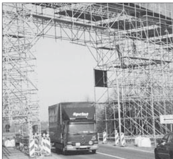
Ein „Tor“ für Finkenwerder: Eine Gerüstkonstruktion aus einem spektakulären Stangen-Gewirr unter dem Förderband des Aluminiumwerks macht es möglich. Foto: Müntz
