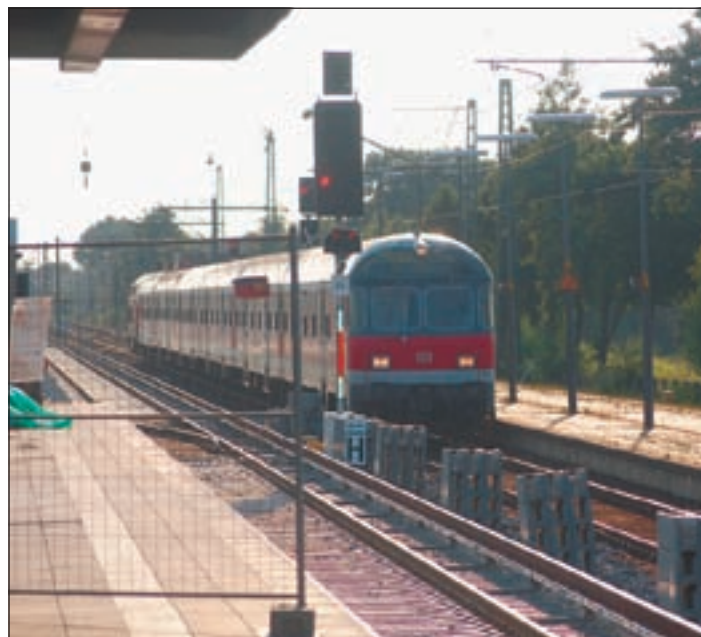
Freie Fahrt für die Bahn: Nach der Behebung der Schäden am Gleisbett auf der Strecke Neugraben - Neu Wulmstorf können die Züge wieder planmäßig rollen. Foto: Koltermann
