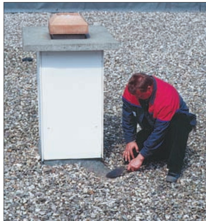
(mG) Mit der Flachdach-Inspektion, die zweimal im Jahr empfohlen wird, sollte der Fachmann betraut werden. Er erledigt die Kontrollen professionell und führt eventuelle Instandsetzungsarbeiten durch. Foto: www.derdichtebau.de
