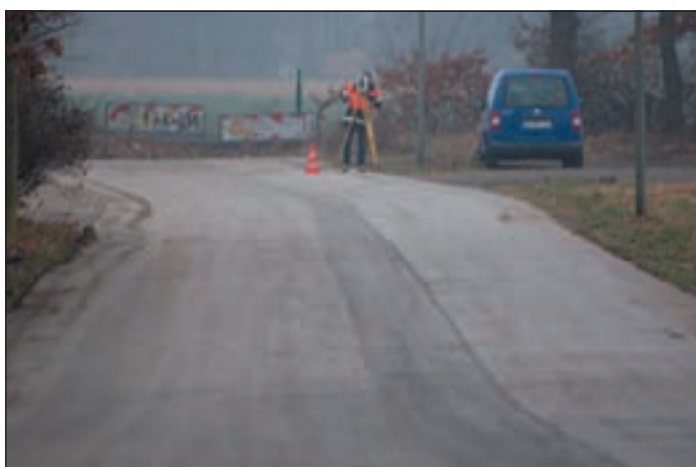
Vermessungsarbeiten am Aschenland: Die Stadtreinigung plant auf dem früheren Areal des Asylantendorfes einen Recycling-Hof. Foto: Koltermann
