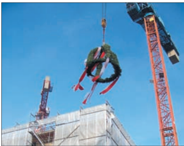
Die Richtkronen über dem Neubau.
