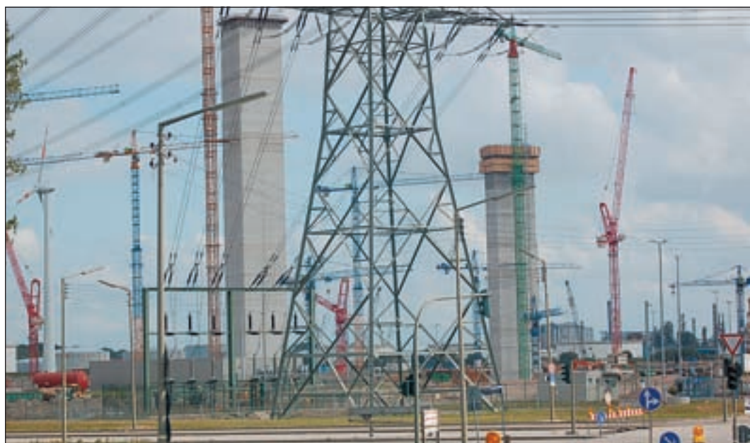
Das im Bau befindliche Kohlekraftwerk Moorburg wird laut Vattenfall um voraussichtlich 600.000 Euro teurer. Foto: Koltermann
