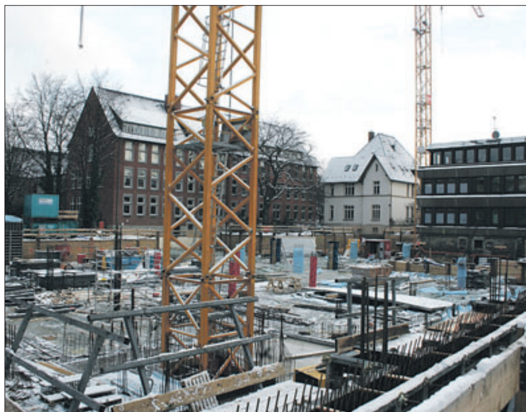
Noch eine große Baustelle, aber mit der Einrichtung des Rathausforums als neues Verwaltungszentrum wird die Harburger Verwaltung in den nächsten Jahren ein ganz neues Gesicht erhalten. Foto: pm
