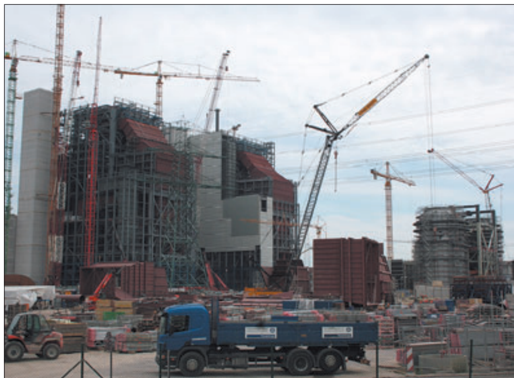
Der Bau des Kohlekraftwerks macht große Fortschritte
