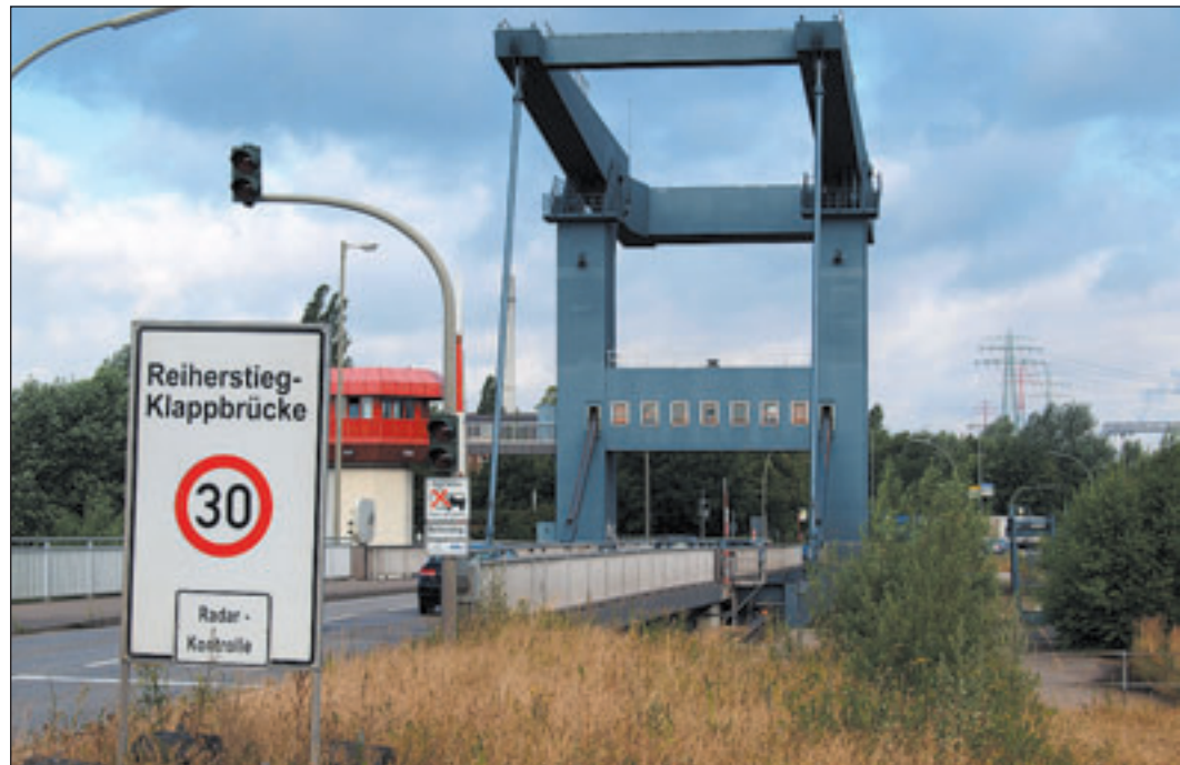
Vom 17. Juli bis zum 7. November wird die Reiherstiegklappbrücke vollständig gesperrt. Foto: Ubben
