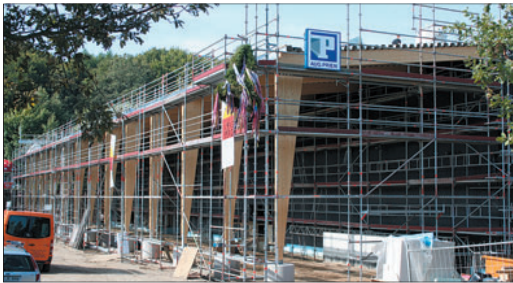
In wenigen Tagen soll das Gerüst den Blick auf den Agrarium-Rohbau frei geben Foto: FLMK
