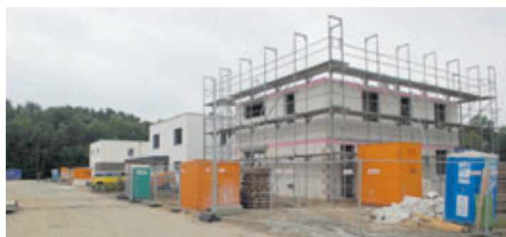
Das Neubaugebiet Fischbeker Heidbrook wächst stetig. Foto: mk
