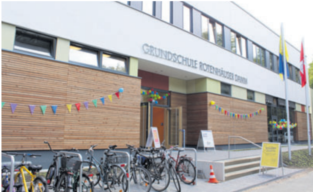
Mit dem neuen Anbau an der Schule Rotenhäuser Damm hat sich die räumliche Situation der Schule um ein Vielfaches verbessert. Foto: au
