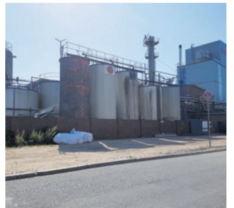
Eine Auflage der Umweltbehörde: Die Erneuerung des Tankfelds. Zurzeit werden die alten Tanks demontiert. Foto: au
