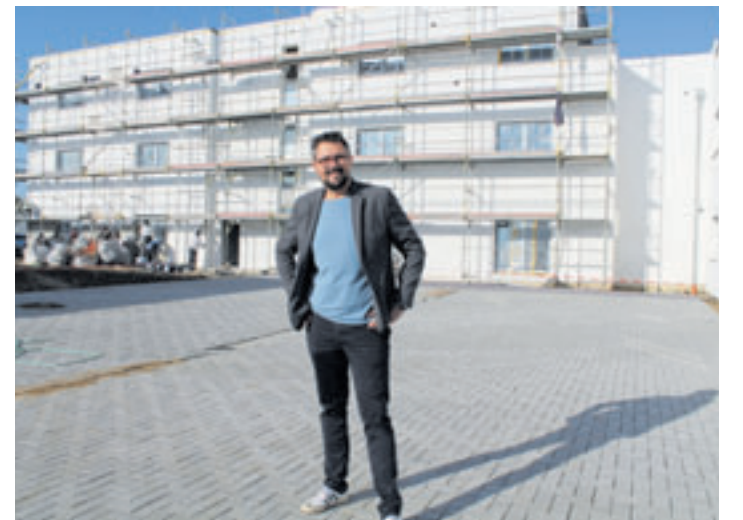
Es geht voran: Der Rohbau ist bald fertig – bereits zum 1. November sollen die neuen Mieter einziehen
