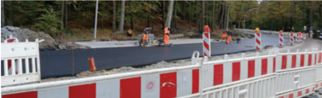
Der neue Asphaltbelag für den Ehestorfer Heuweg wurde größtenteils aufgetragen
