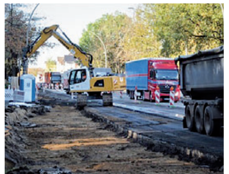
Schon die Einrichtung der Baustelle verursachte Staus
