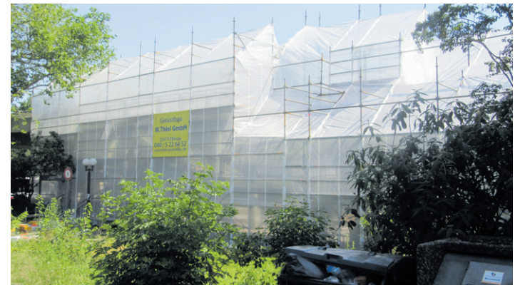
Die Sanierung der Cuxe-Querung hat begonnen. Fotos: W. Marsand
