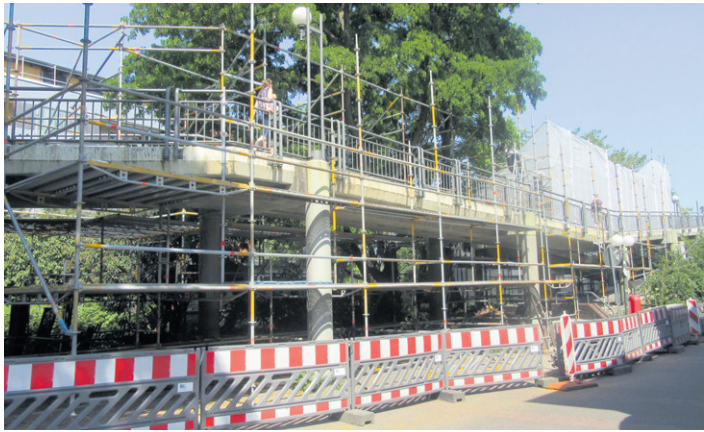
Farb-Pigmente und Schutzanstrich sollen in einem Abwasch aufgetragen werden.
