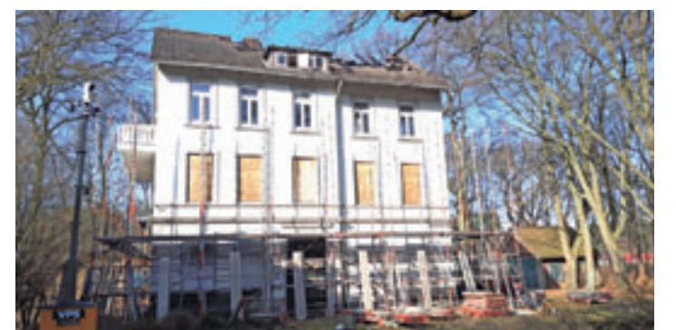
Der Alte Jägerhof wurde unter der Woche eingerüstet. Die Finanzbehörde erklärte, dass unter anderem das Dach repariert werden soll.
