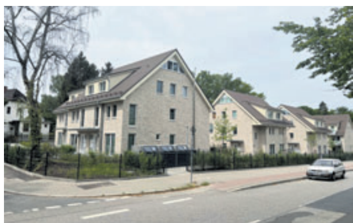
Die Neubauten in der Vogelerstraße 2-8/Milchgrund 33-39 Foto: EBV
