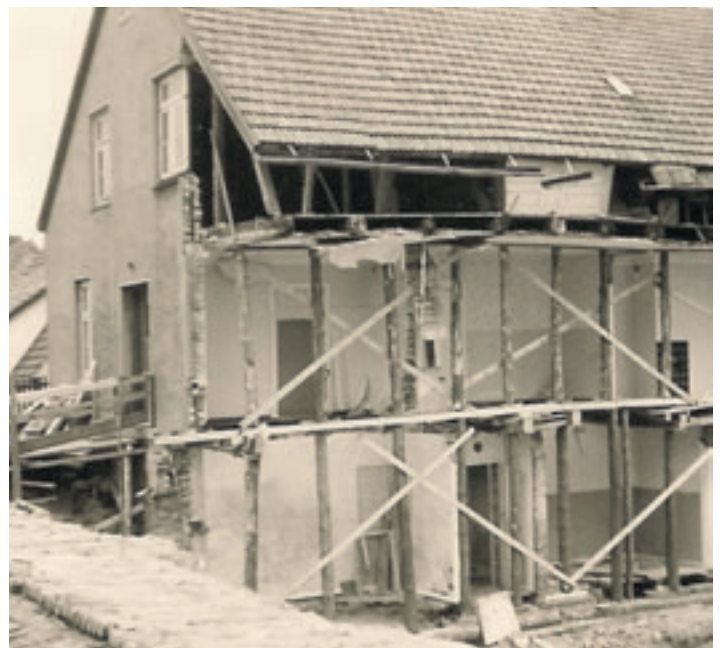
Die Decken dieses Wohnhauses in Moorburg mussten notdürftig mit Baumstämmen vor dem Zusammenbrechen gesichert werden
