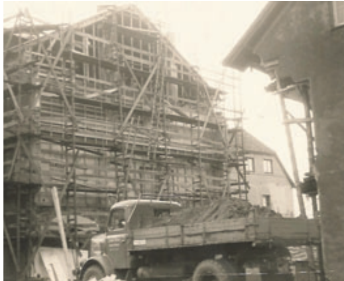
Die Sanierung der beschädigten Gebäude wurde rasch in Angriff genommen
