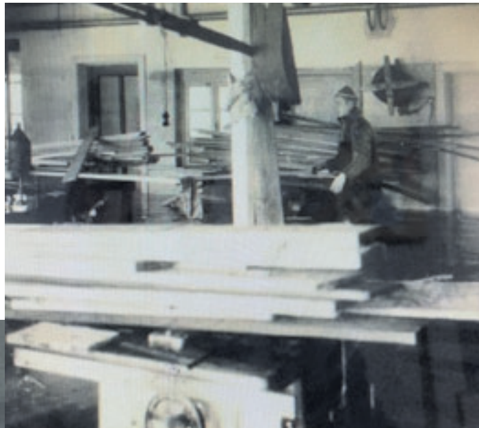
Die durch die Flut 1962 angerichteten Schäden in der Firma Holst waren schwer Foto: Holst
