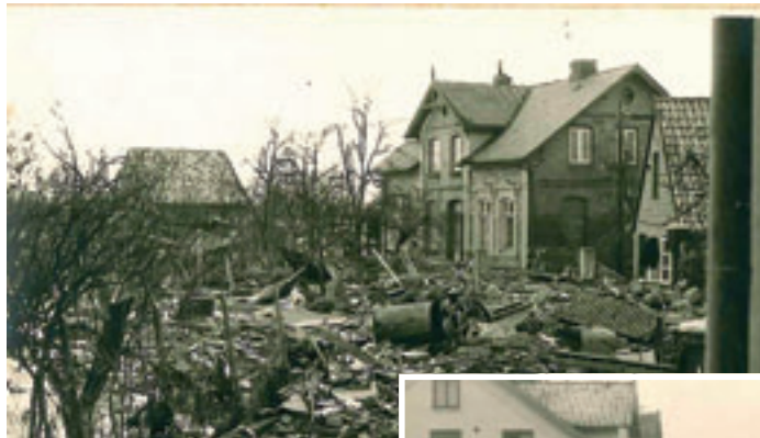
Die Zerstörungen durch die Flut 1962 waren auch in Moorburg riesig.
