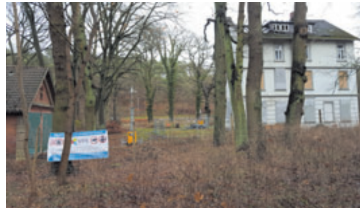
Der ausgebrannte „Alte Jägerhof“ soll nun laut Senat bald abgerissen werden
