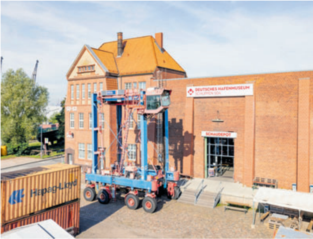
Kopfbau des Deutschen Hafenumuseums, Standort Schuppen 50A,
